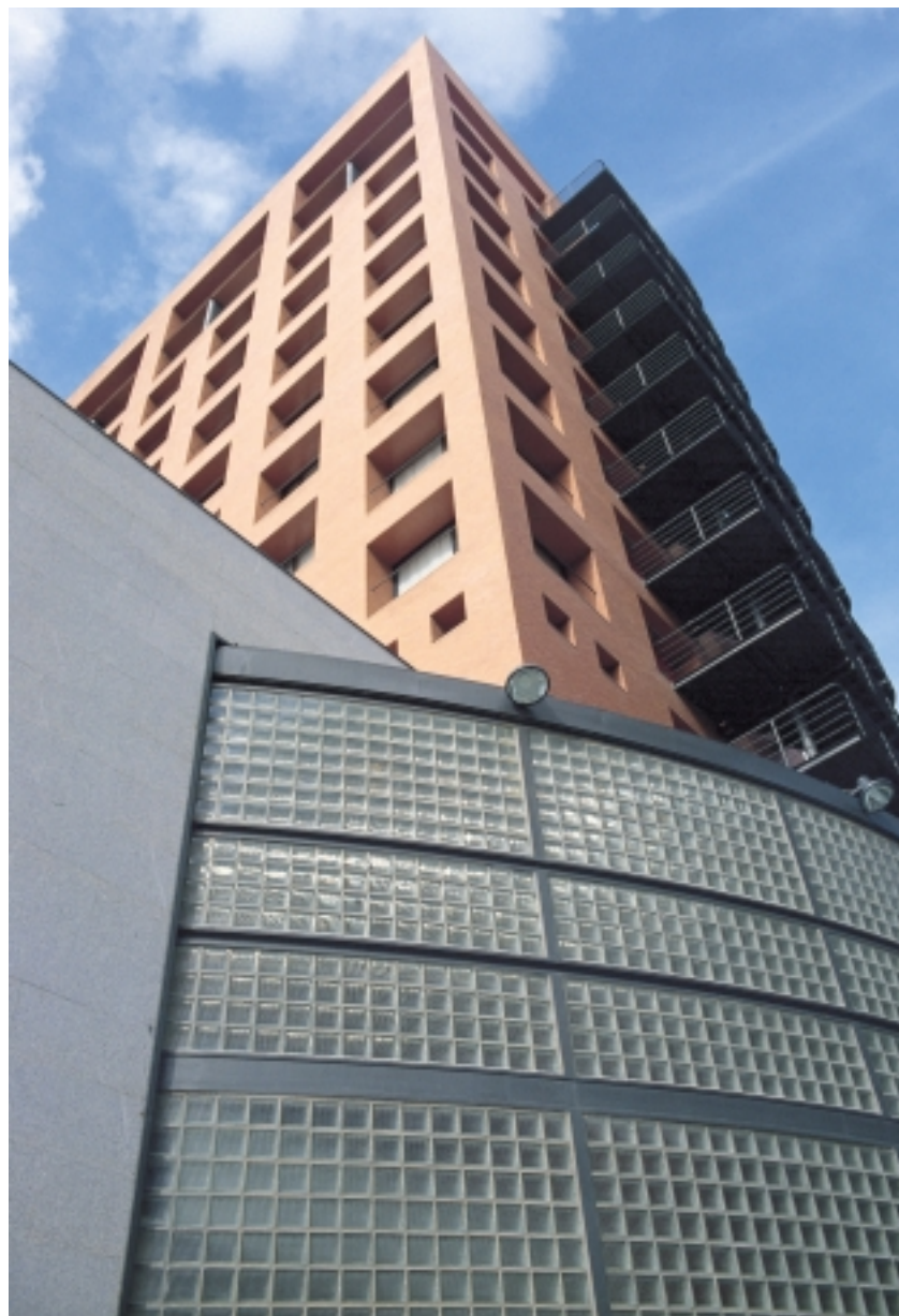
Sede del Consejo Económico y Social, que se erige sobre el solar del antiguo Edificio "Pueblo", en la calle Huertas.
